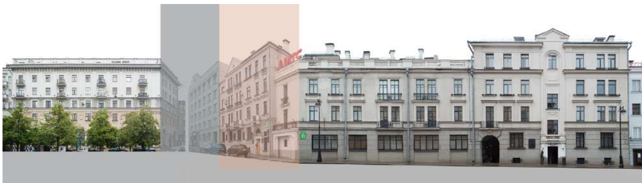
Фото 1. Вид на здание с рекламным элементом со стороны ул. К.Маркса (панорама).
