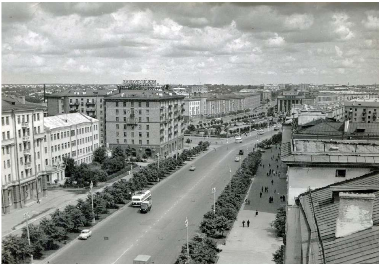
..... Вид на площадь Якуба Коласа со стороны проспекта Независимости (от пл. Победы).
