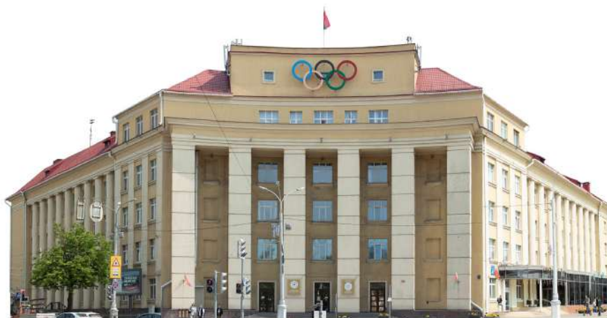
Фото № 7: Фотофиксация существующего состояния фасада здания по пр. Независимости, 51, к1
