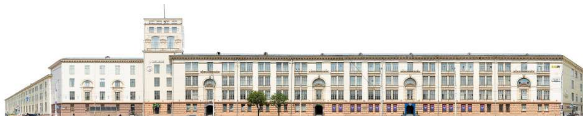
Фото № 3: Фотофиксация существующего состояния фасада здания по ул. Кульман, 1, к. 3
