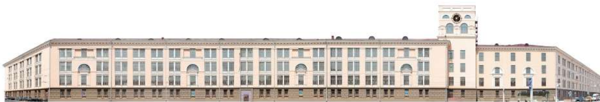
Фото № 2: Фотофиксация существующего состояния фасада здания по ул. Красная, 23
